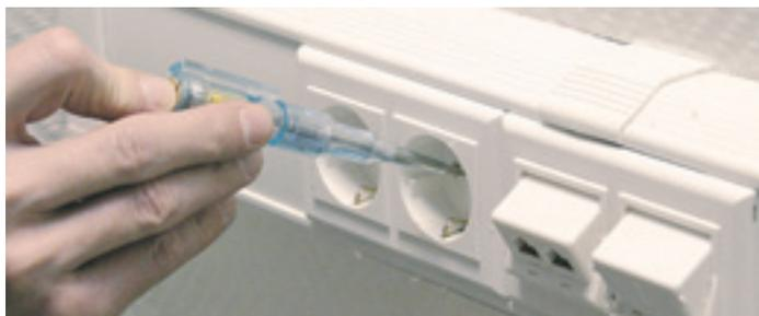
**Пробники** электрические и **тестеры** напряжения помогут проверить наличие напряжения в электросети или ином проводнике в случае демонтажа электроустановочных изделий и других приборов, находящихся под напряжением. Пробники показывают наличие или отсутствие напряжения, а тестеры определяют также место обрыва высоковольтного провода и наличие электромагнитного излучения, то есть позволяют работать бесконтактным способом.
